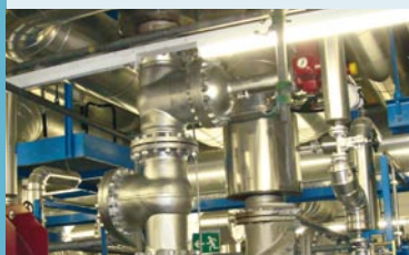
Maintenance de robinetterie
